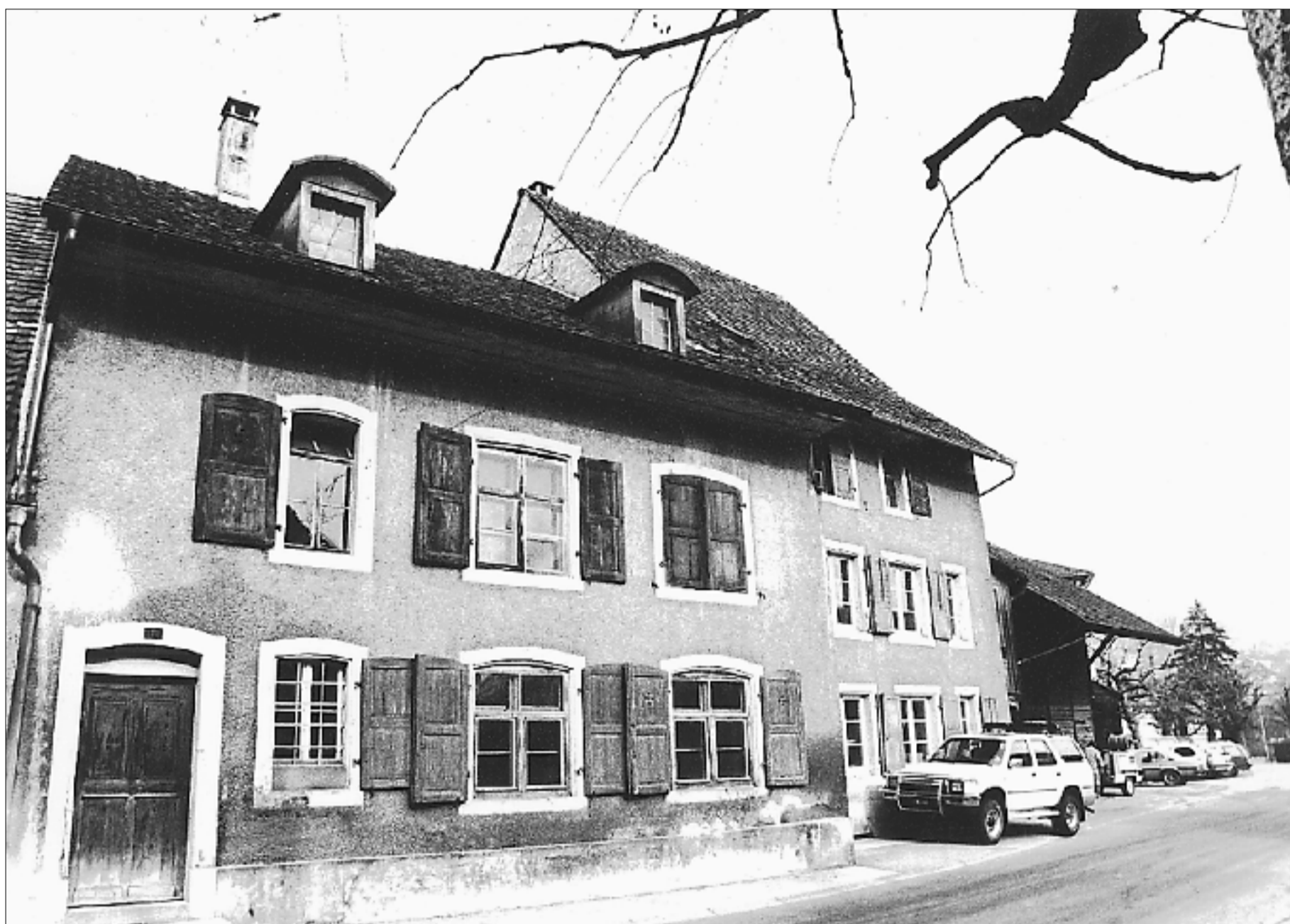
So sah die Schulstrasse 1-3 noch vor einem Jahr aus.
